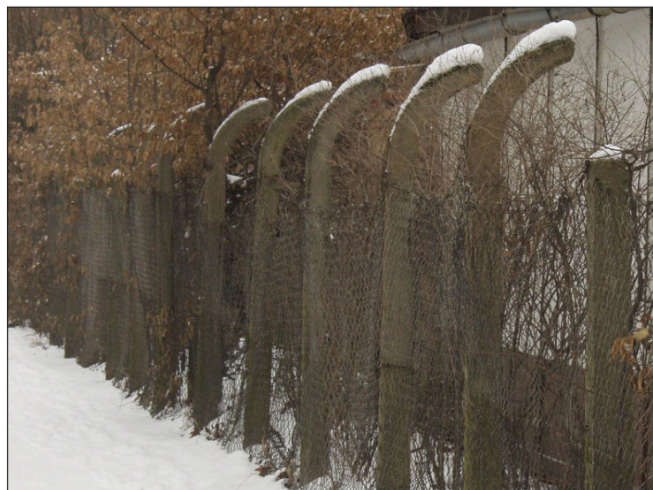
Lagerzaunreste zwischen TV-Sportplatz, Wehrinselstraße und dem dahinter liegenden Rosengarten.
