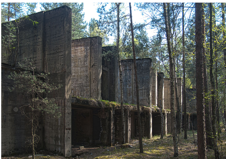
Reste des Komplexes in Brożek, 2011 - Das heutige Foto zeigt Reste der späteren Industrieanlage, nicht das frühere Dorf Scheuno. - Stefan Fussan, 22.04.2011; Wikimedia Commons; CC BY-SA 3.0.
