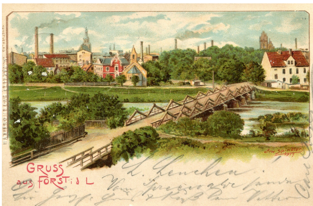
Brücke zur Stadt Forst - Die Ansichtskarte dokumentiert den Flussraum, zu dem Scheuno, Koyne und Forst gehörten. - Erwin Spindler; Sammlung Heidi und Frank Gaitzsch / IfL; gemeinfrei.
